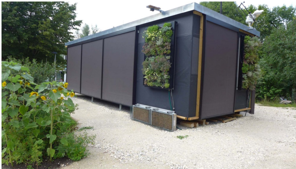
ForschungsKUBUS mit Living Walls und geschlossenen Textilscreens. Foto: DITF
