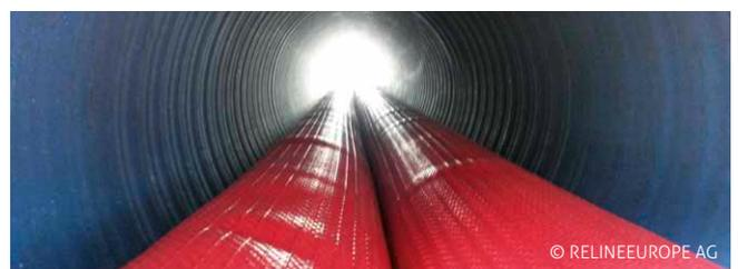
In ein Abwasserrohr eingezogenes 2-teiliges Wärmetauscherpaneel
