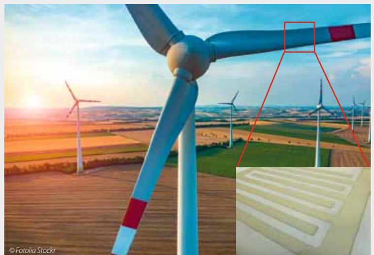
*Gedruckte Interdigitalstruktur, Anwendungsmöglichkeit innerhalb von Rotorblättern*
