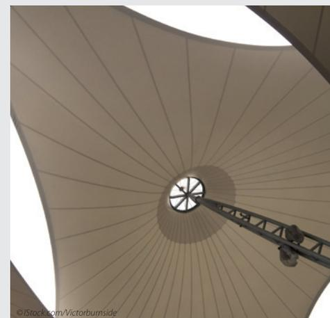
Anwendung chemisch und thermisch stabiler Fasern im Membranbau
