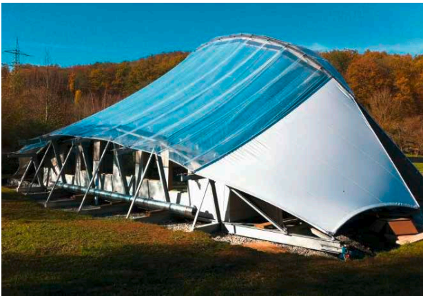
Eisbärpavillon: textiler Membranbau mit höchster Energieeffizienz und verlustfreiem Wärmespeicher.
